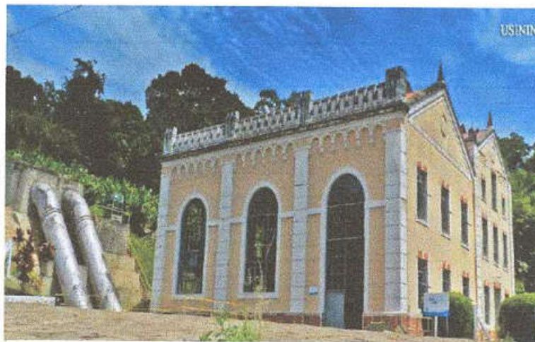
Figura 19: Pequena Central Hidrelétrica Lençóis Fonte: Prefeitura Municipal de Macatuba (2015).
