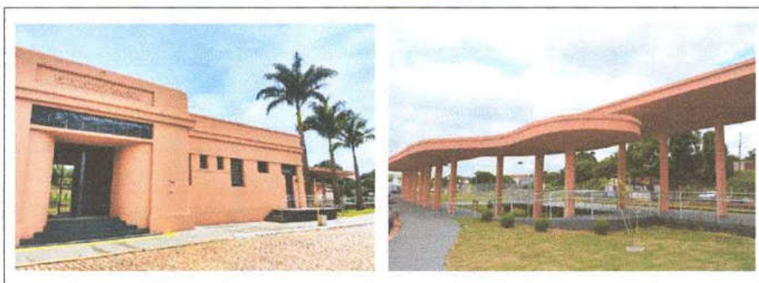
Figura 33: Estação Ferroviária Sorocabana revitalizada Fonte: Prefeitura Municipal (2019).
