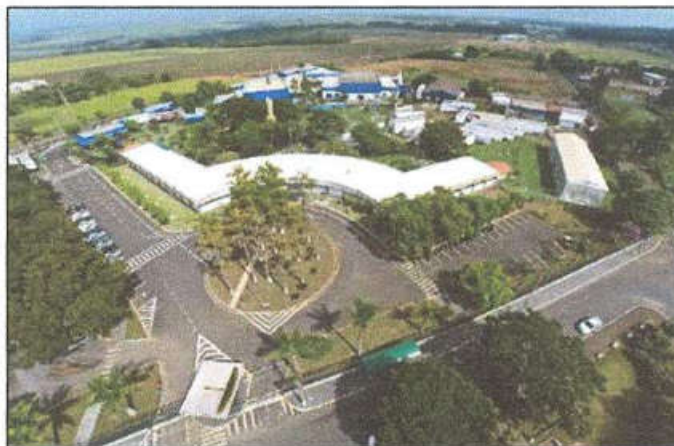
Figura 30: Instalações do SENAI Fonte: SENAI (2015).
